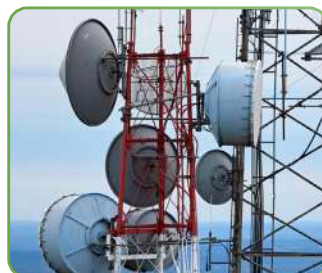
Centros de telecomunicaciones o repetidoras
